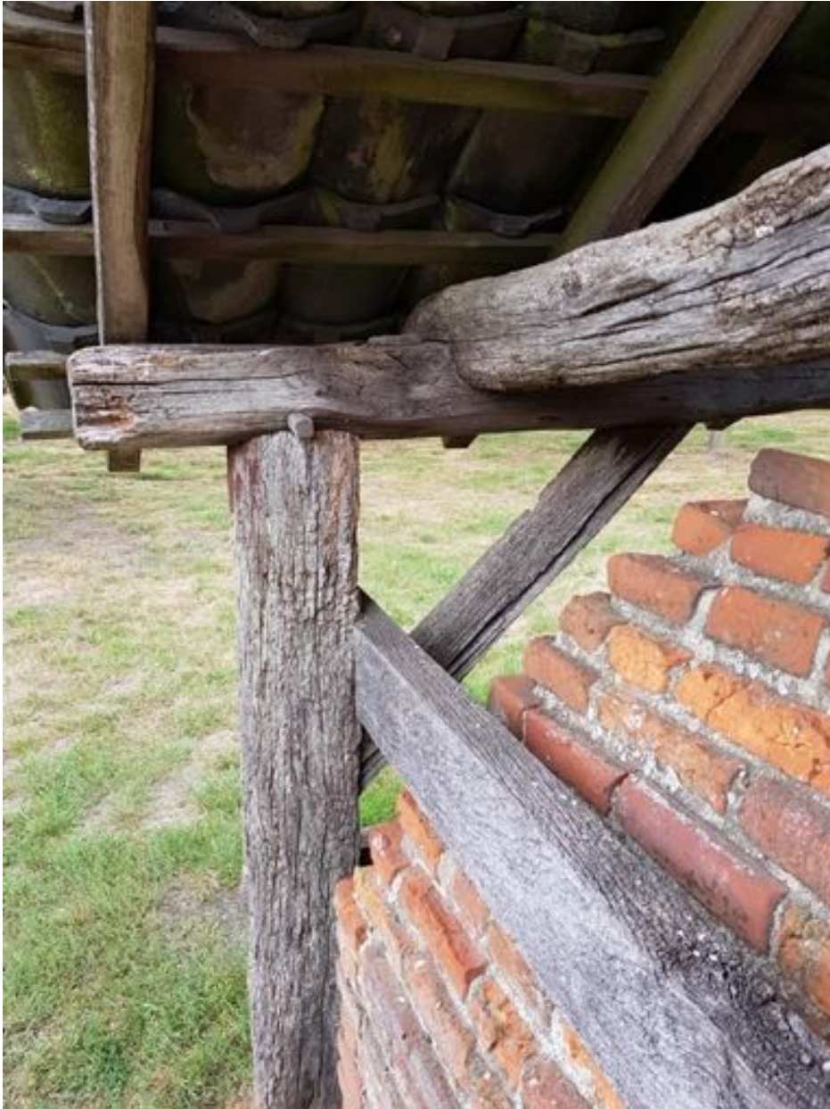
Het houtwerk, stenen en pannen zijn waarschijnlijk grotendeels nog origineel. Het cement en de fundatieplaat zijn uit 1972.
